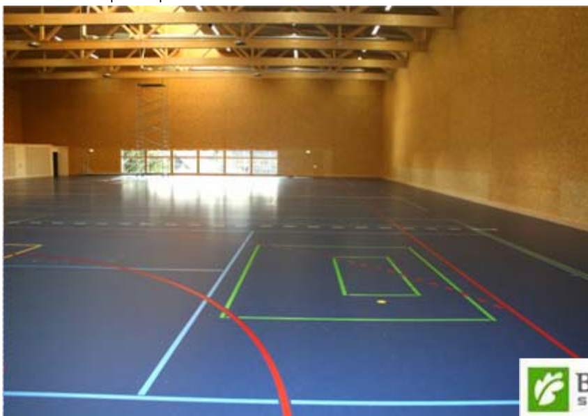
Oberbelag mit Polyurethan-Beschichtung
